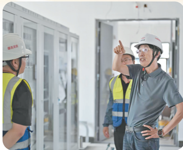
刘永进与现场技术人员在雄商高铁项目深圳东配电站部署施工工艺。 李晓宁 摄
