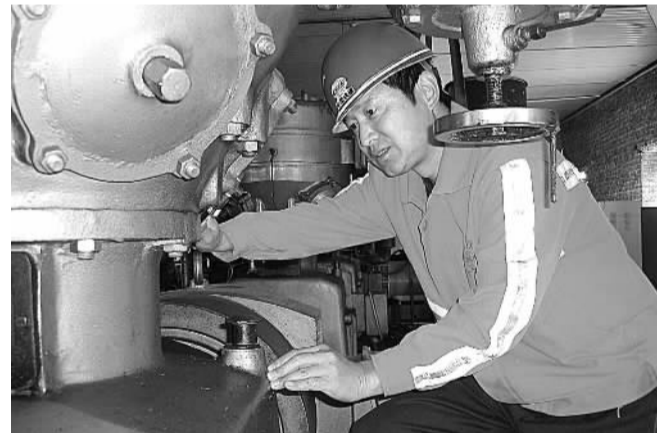
图为张丛林正在维修保养空压机。
