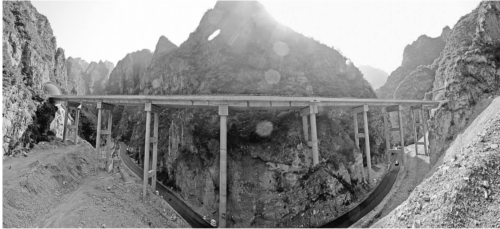
十六局集团五公司担负施工的张石高速公路二期二(三)合同段,位于河北省张家口蔚县境内,路线穿越京西绿色大峡谷——飞狐峪景区。经过全体参建员工四年多的艰苦奋战,主体工程于近日提前建成完工,为全线今年十月竣工通车创造了有利条件。图为穿越飞狐山谷的四十里岭大桥。杨卧龙 刘海亮 摄
