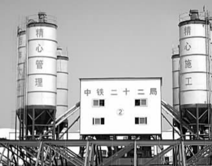
混凝土搅拌站
