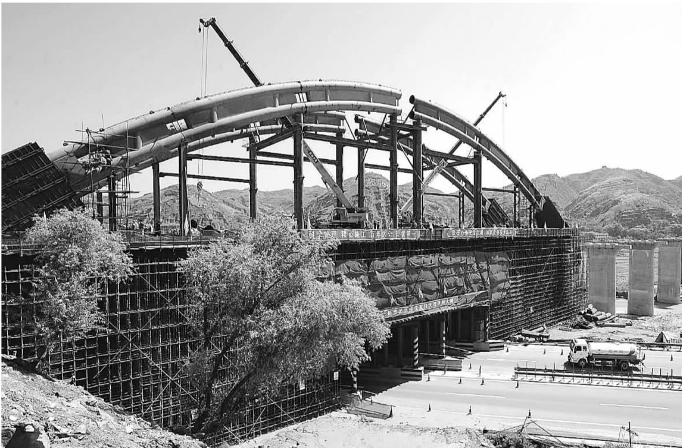
由十六局集团承建的大中银铁路SJS-1标段苗家坪大理河特大桥长667.2米,桥隧相连,地质复杂。项目部针对跨铁路、公路现浇梁施工的实际,在大桥80米钢管拱架施工中,将吊梁场地放到了梁面上,采用30吨吊车就实现了吊装,避免了对青银高速公路行车的影响。图为7月20日,苗家坪大理河特大桥正在加紧施工。朱洪山 周金龙 摄
