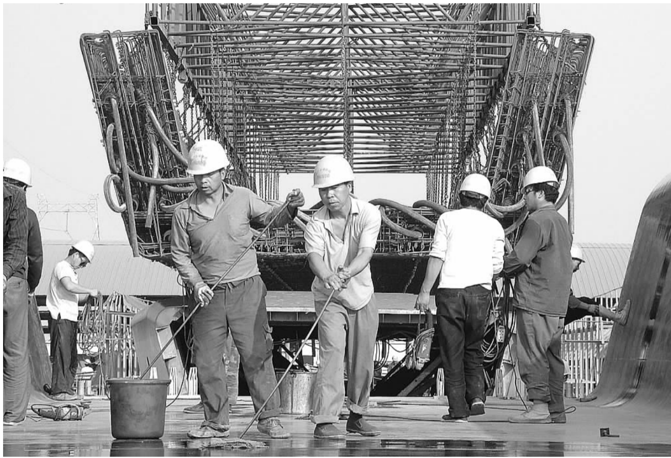
7月21日,京沪高速铁路北冯制梁厂建设工地,十二局集团三公司的建设者们冒着高温奋战在生产一线,为保工期不误架梁加班加点,全力加快施工进度。
