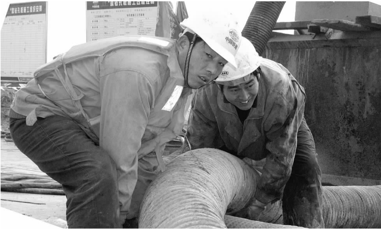
近日,担负宜汉铁路汉江大桥施工的十二局集团一公司宜汉铁路项目部全体员工,不分昼夜奋战在工地上,“大战120天,抢在汛期前,圆满完成水中桥墩主体工程!”图为火热的工地一角。 本报记者 武羽 摄
