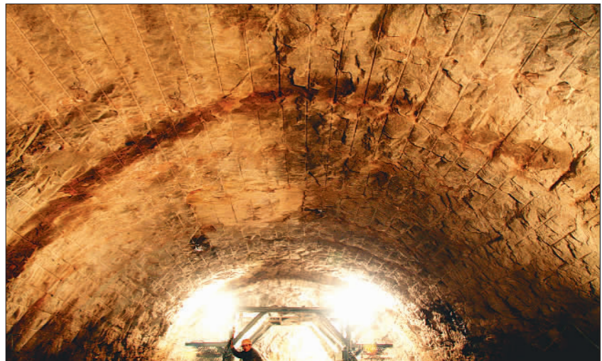
▲胶州湾海底隧道光面爆破 鲍汝昌(十九局集团五公司)摄
