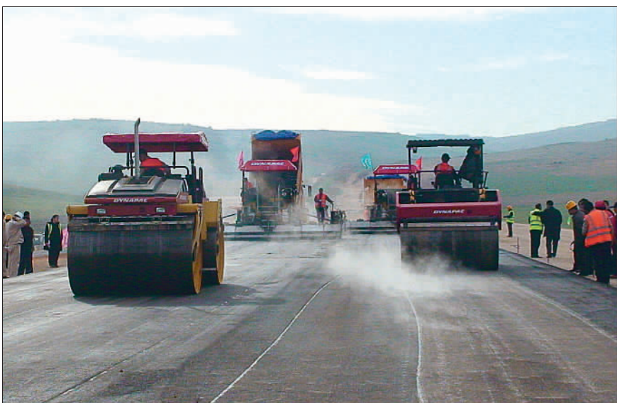
▲路面沥青碾压现场
