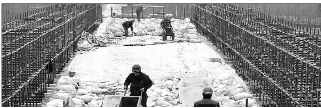
▲薛常特大桥现浇支架连续梁施工
