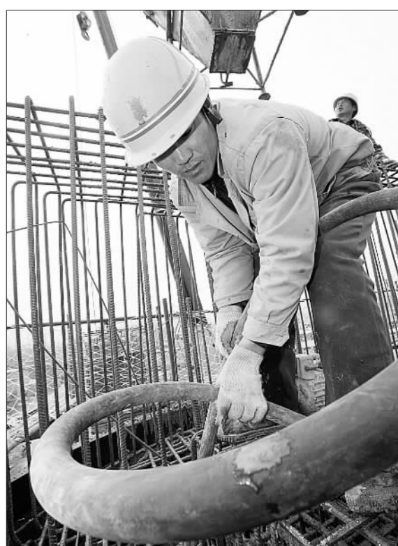
▲捣固混凝土
