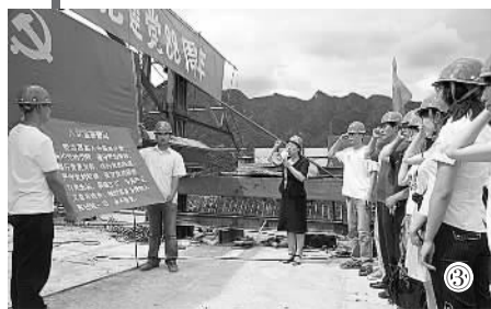
图③为7月1日,京承高速公路三期工程清水河2号大桥刚刚完成施工的桥面上,二十二局集团一公司40多名老党员面对鲜红的党旗,庄严地进行入党宣誓。 王秉良 解丽 摄
