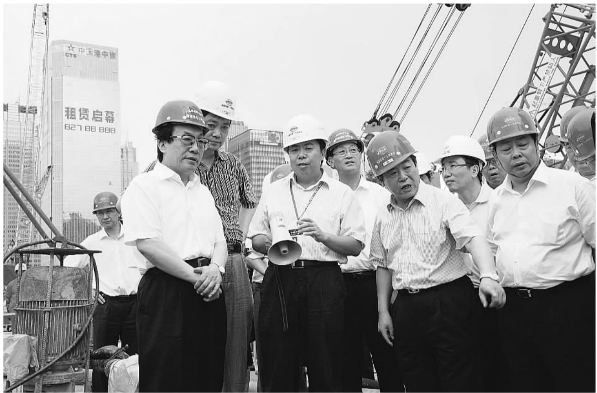
图为6月28日,刘志军(前左一)、卢春房(后中)一行在广深港客运专线福田站施工现场听取赵广发(前右二)汇报。 刘文 摄
