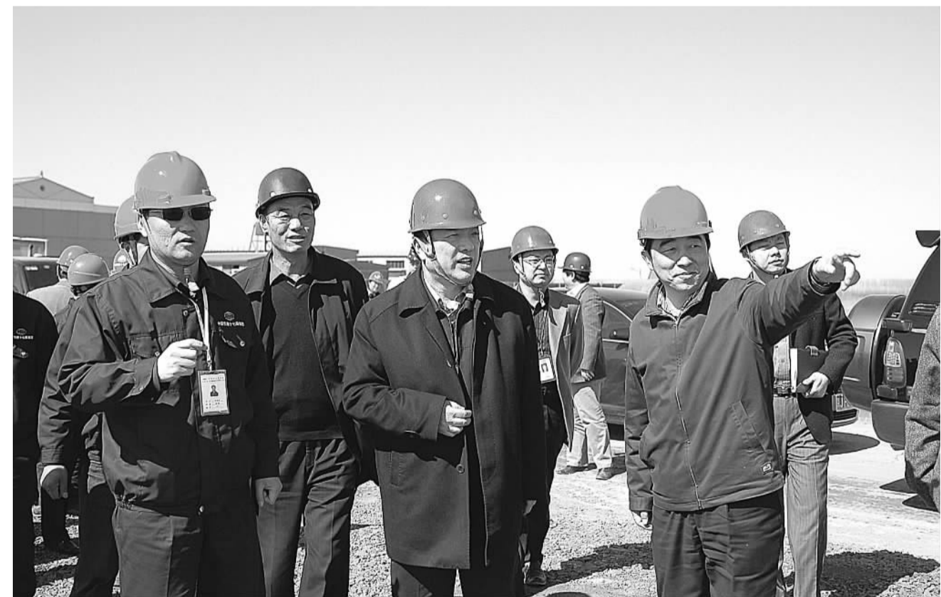
日前,铁道部原副部长、京沪高铁公司董事长蔡庆华(右二)在十七局集团京沪项目部常务副总经理梁毅(右一)的陪同下检查该项目进场准备情况,对施工便道、梁场征地、拌合站试验室建设进度表示满意,并勉励他们继续发扬京津客专的优良作风,在京沪线树起榜样。
