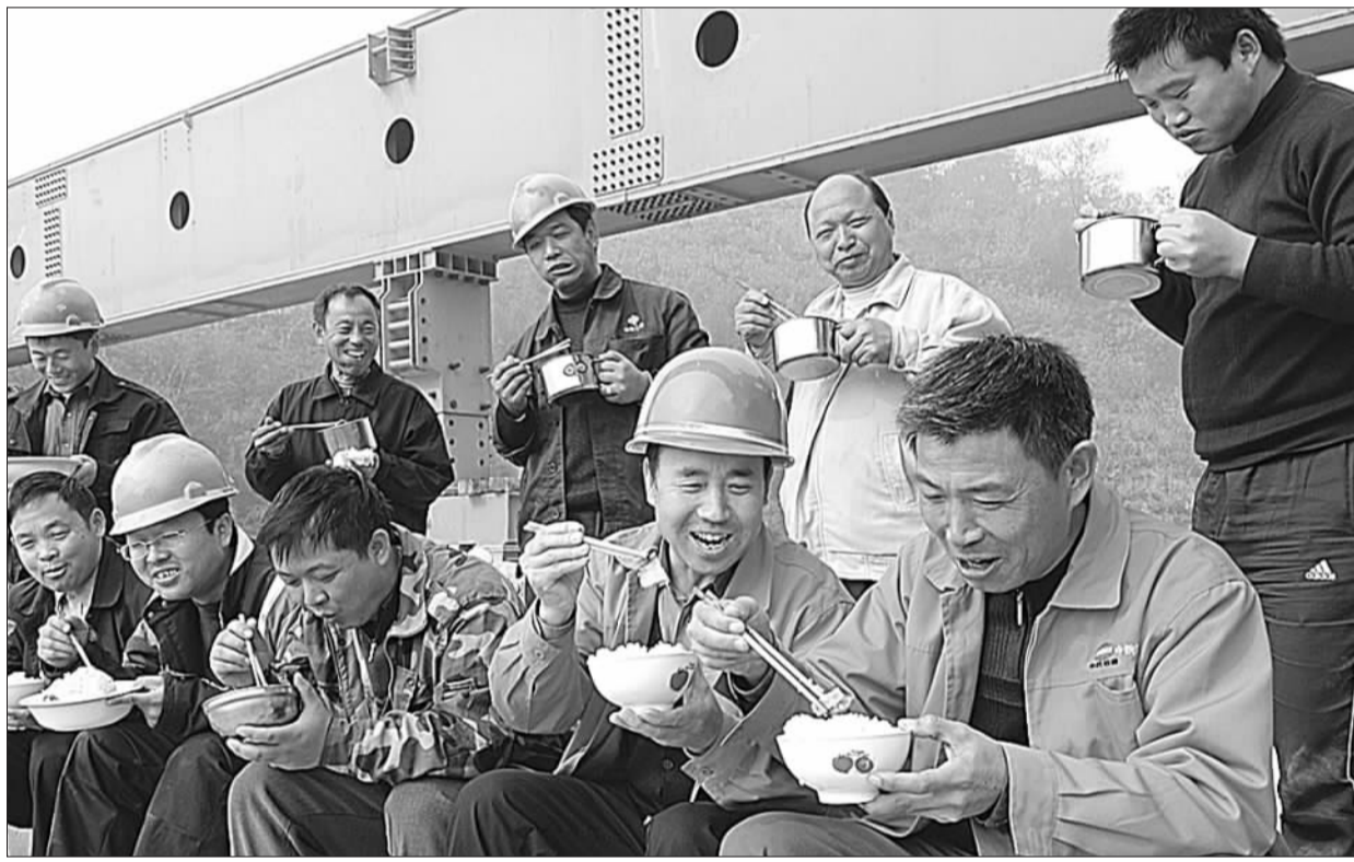
十二局集团四公司合武梁场项目部,共产党员、共青团员争当技术标兵和岗位能手,经过半年的实际操作,模板制作、钢筋布网、梁片生产等全部实现了一条龙生产作业。图为职工与项目部书记张新民(前右二)一起乘制梁间隙吃午饭。 安剑承 摄
