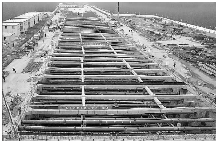
▲位于江南的隧道出口正在开挖
