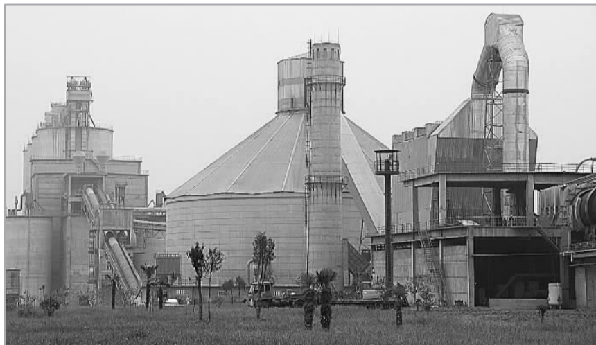
安徽荻港海螺水泥厂水泥熟料生产线
