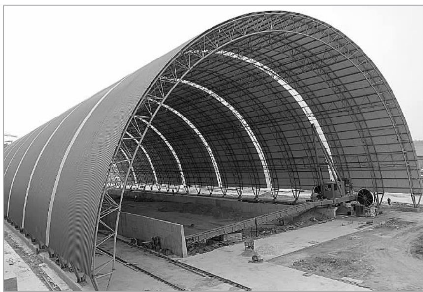
在建中的华润水泥厂辅助原料堆场主体及网架
