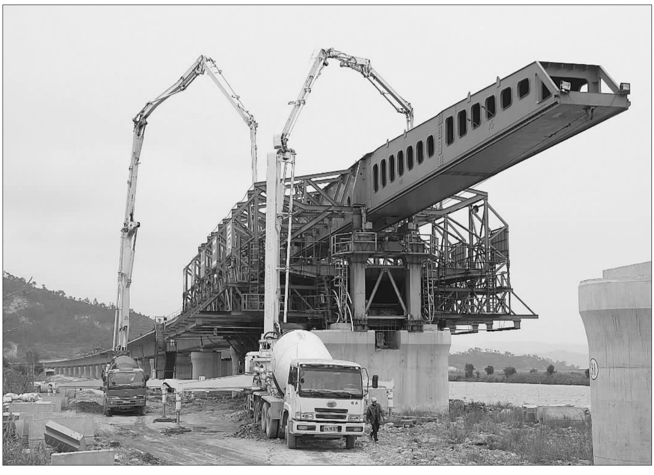
十五局集团在温福铁路(福建段)I标段施工中,独家成立移动模架制梁项目部,采用移动模架法逐跨制梁,同时进行全方位、全过程管理和控制,成为温福客专全线的一个亮点,自2006年12月16日到目前已制梁104孔。 本报记者 赵延风 摄
