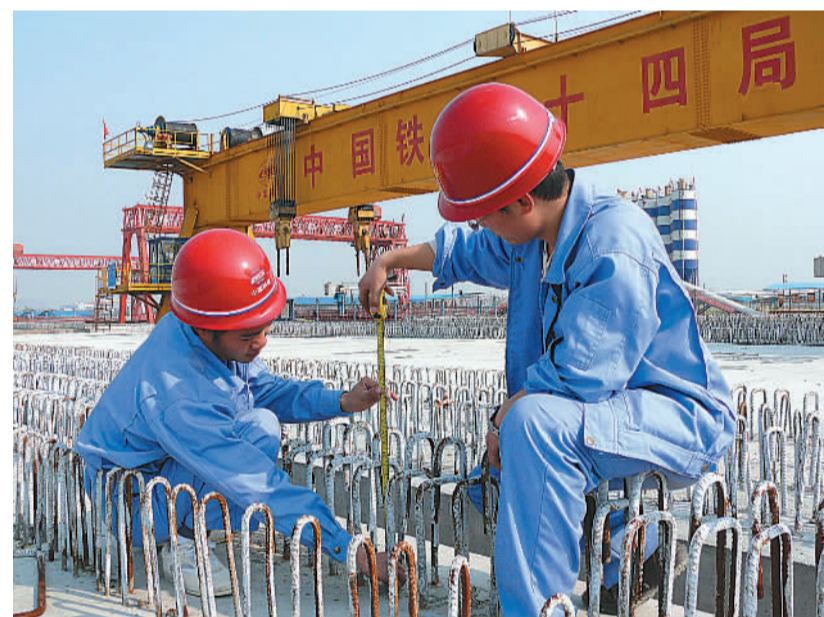
十四局集团广深港客运专线指挥部,着力抓好重、难点工程的节点工期,实现了进度、质量同步提高。图为工程技术人员正在测量外露钢筋。 张建宾 摄
