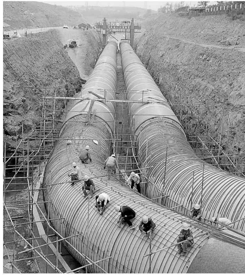
十六局集团承建奥运配套工程南水北调PCCP段四标工程的建设者们,正倒排工期,加紧进行管道安装。据悉,管道安装主体工程将于4月完工。本报记者 威海忠 摄
