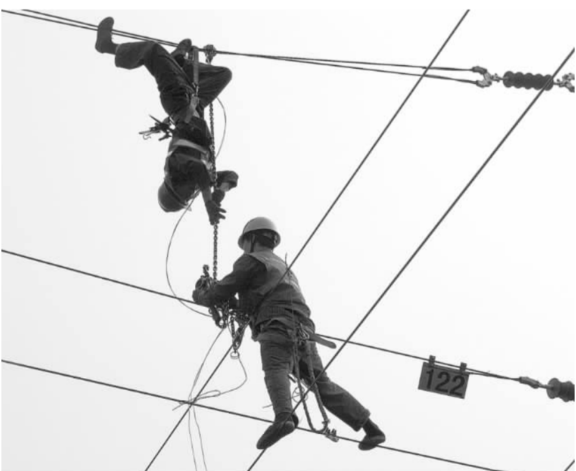
二十四局集团上海电务电化公司职工在沪杭既有线良山站电气化高空作业中,“用精品说话,让平安验证”,取得佳绩。庄浩 周丽生摄
