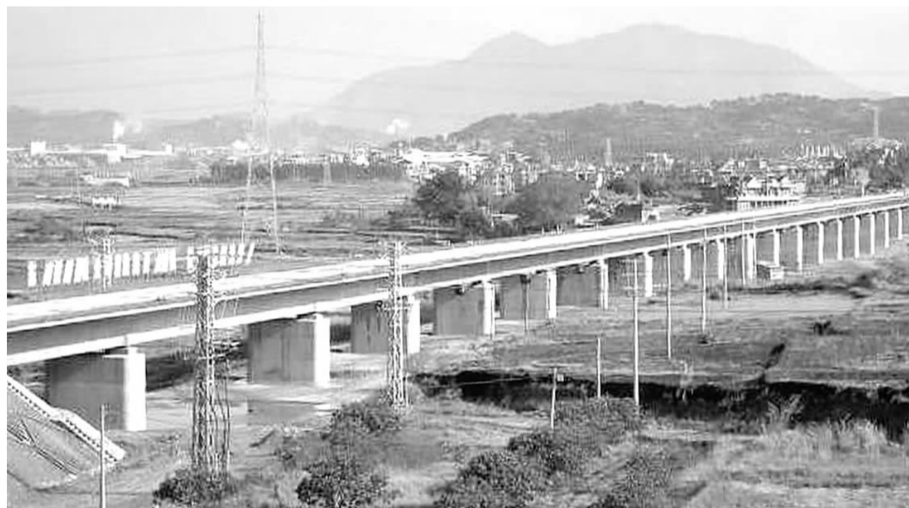
经过二十一局集团三公司职工一年多的努力,春节期间,福厦客运专线首座特大桥900吨整体箱梁顺利完成架梁任务。图为已建雄姿的前尾特大桥。
