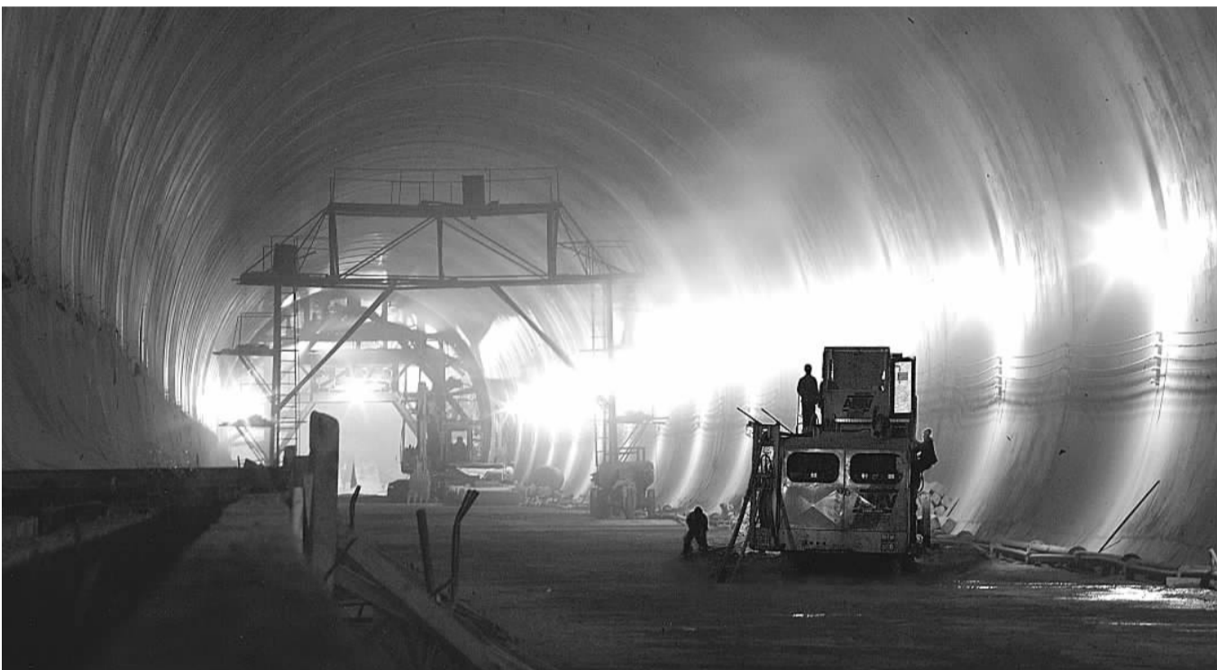
十六局集团承建的郑(州)西(安)铁路客运专线双洞隧道解决了黄土层大断面隧道安全快捷开挖的世界级难题。图为双洞隧道施工现场。本报记者 成海忠 摄
