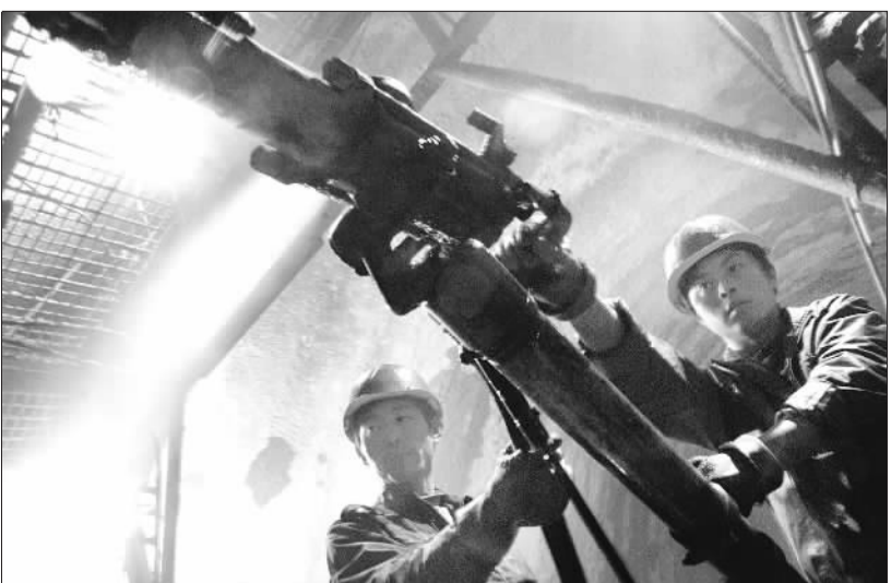
日前,由十二局集团一公司承建的四川省达成铁路天台寺双线重瓦斯隧道安全顺利贯通。该隧道全长3006米,被定为全线重点工程。本报记者 武羽 摄
